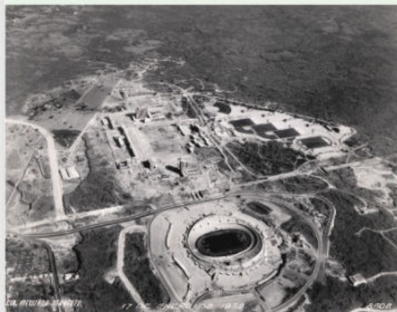
Figura 4.25 Construcción de Ciudad Universitaria en 1952.
